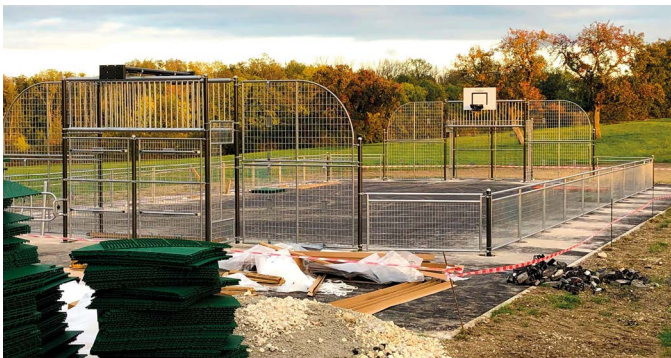
Travaux du terrain multisports.
